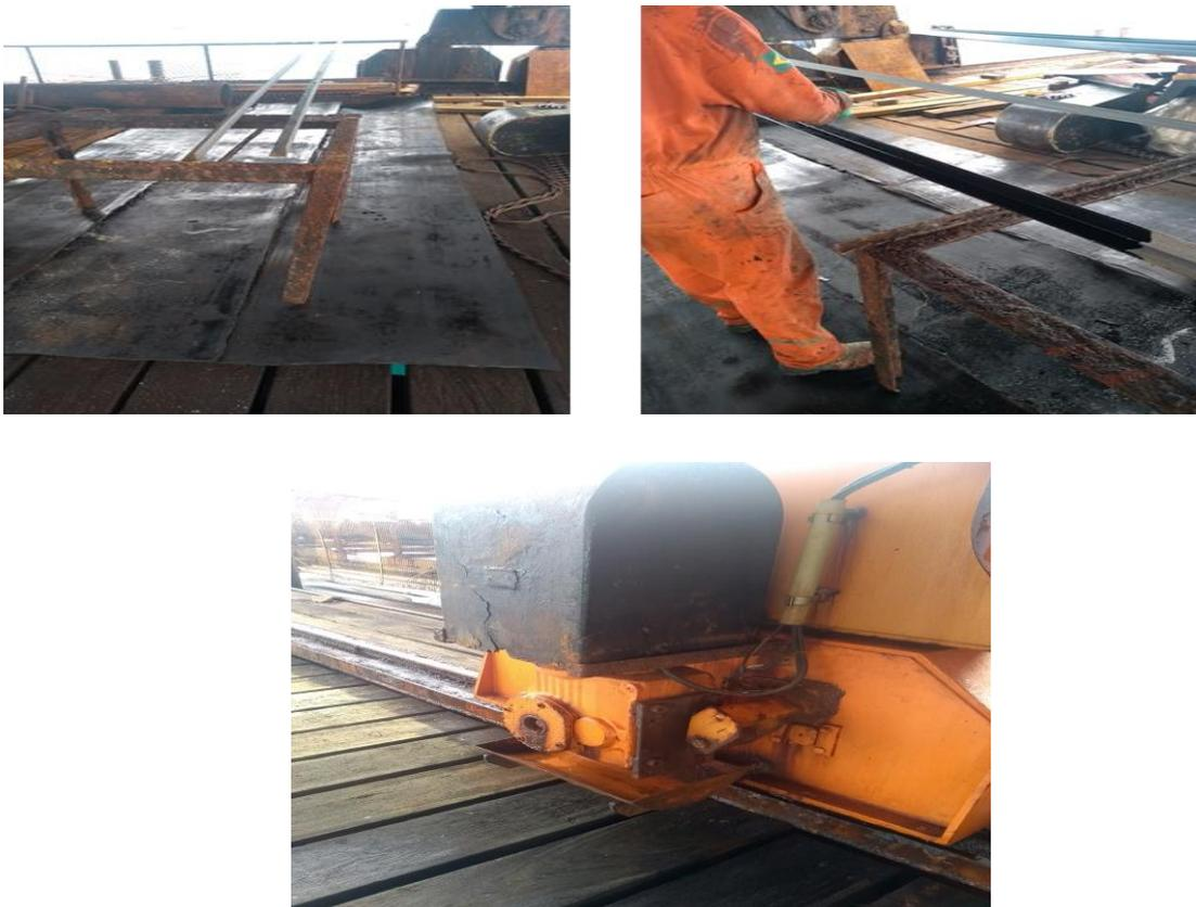
**Figura7. Esteiras adaptadas ao trabalho sem risco de queda de materiais ao mar. (A e B) e na foto (C) motor do DB revestido e com anteparo para evitar gotejamento**
