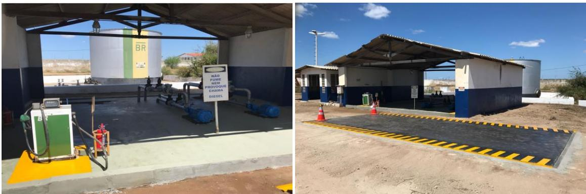
**Figura 11. Reforma no Sistema de Armazenamento e abastecimento na Gerência em terra.**
