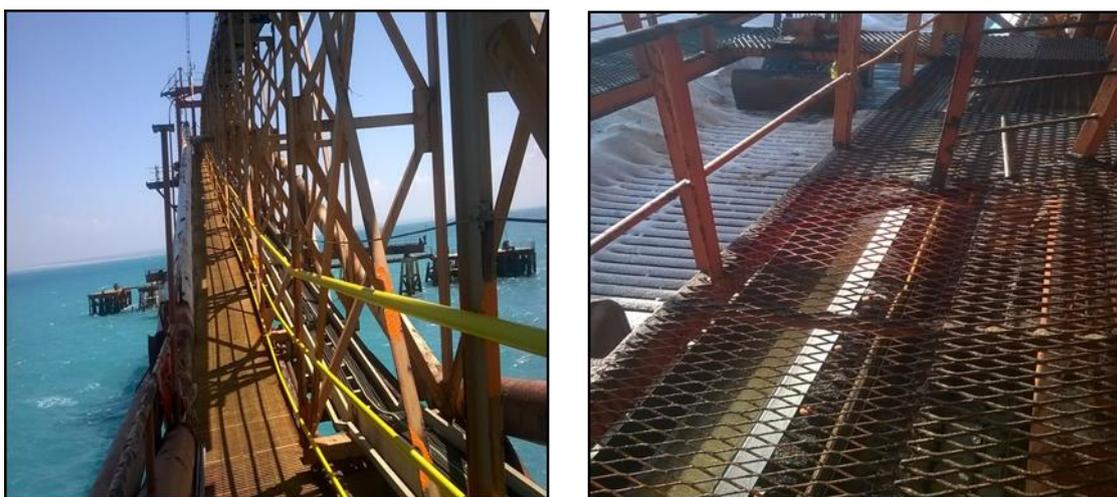
**Figura9. Grades do piso recuperado ao longo da ponte de carregamento. (A e B)**
